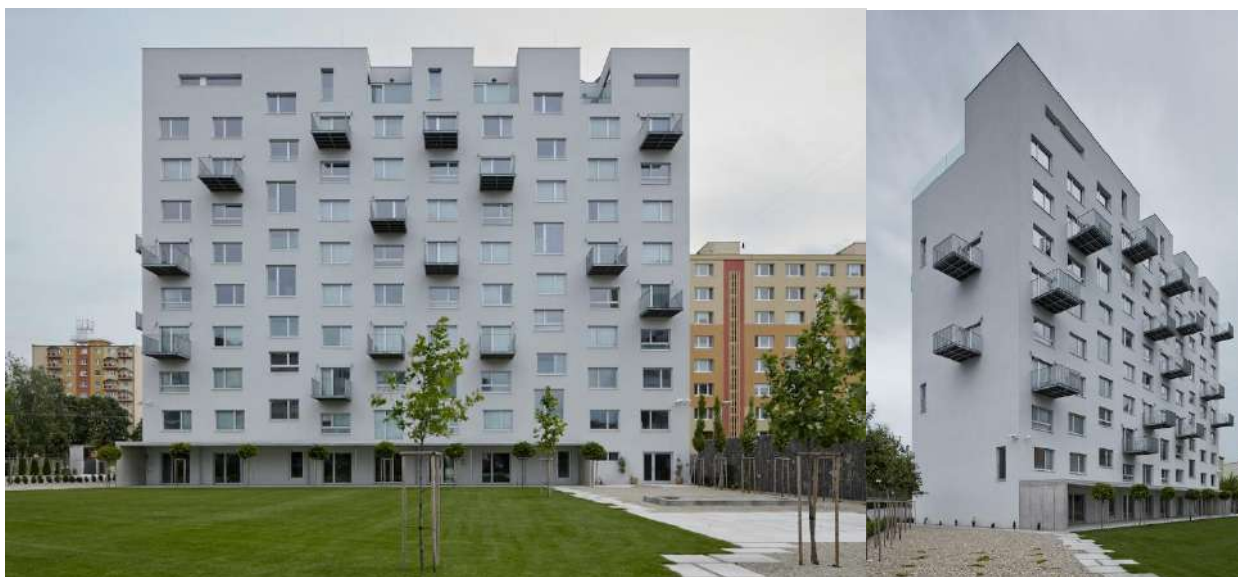
Рис. 9. Пример реконструкции панельного дома в Римавска-Собота (Словакия)
