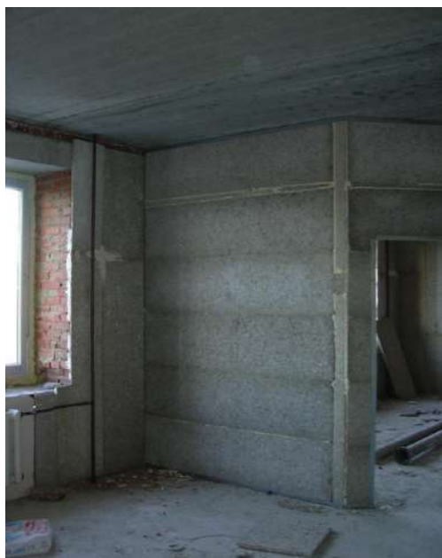
Рис. 1. Применение материалов на основе магнезиального оксихлоридного цемента в качестве утеплителя и элемента несъемной опалубки
