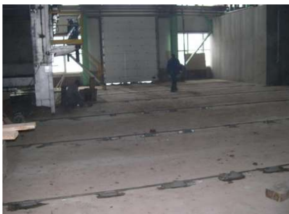
Рис. 2. Установка маячных реек и приготовление смеси в принудительном смесителе
