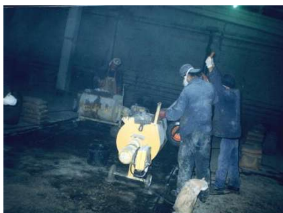
Рис. 2. Установка маячных реек и приготовление смеси в принудительном смесителе
