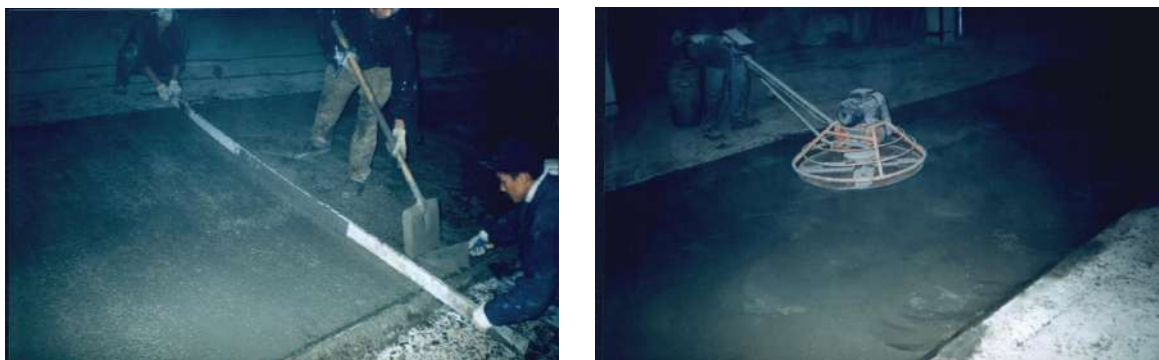
Рис. 3. Разравнивание и заглаживание уложенной смеси
