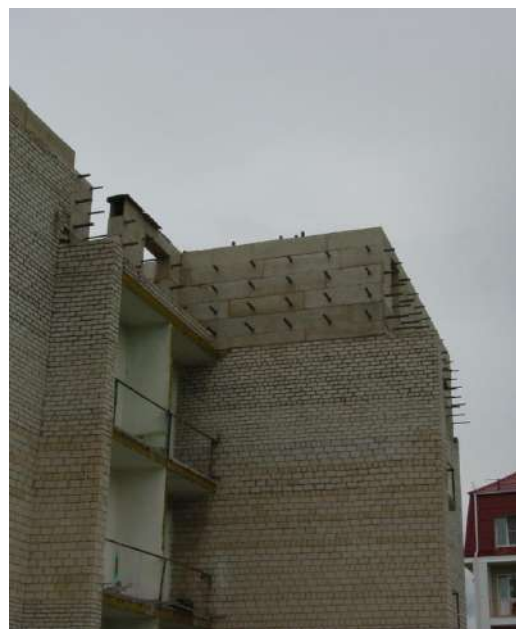
Рис. 1. Применение материалов на основе магнезиального оксихлоридного цемента в качестве утеплителя и элемента несъемной опалубки
