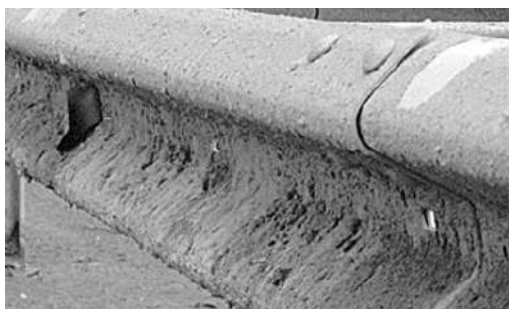
Рис. 3. Световозвращатели находятся под слоем грязи
