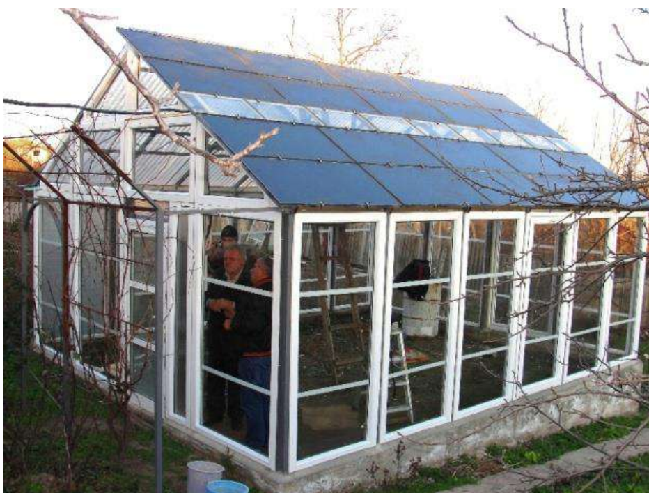
Рис. 6. Вариант монтажа солнечных элементов.
