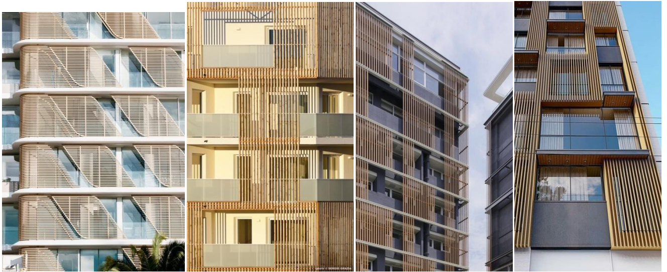
Рис. 6. Использование деревянных обрешеток для модернизации экстерьера
