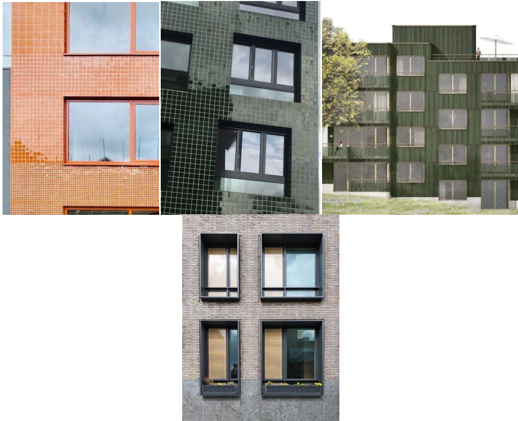
Рис. 9. Отделочные плиты на фасаде здания
