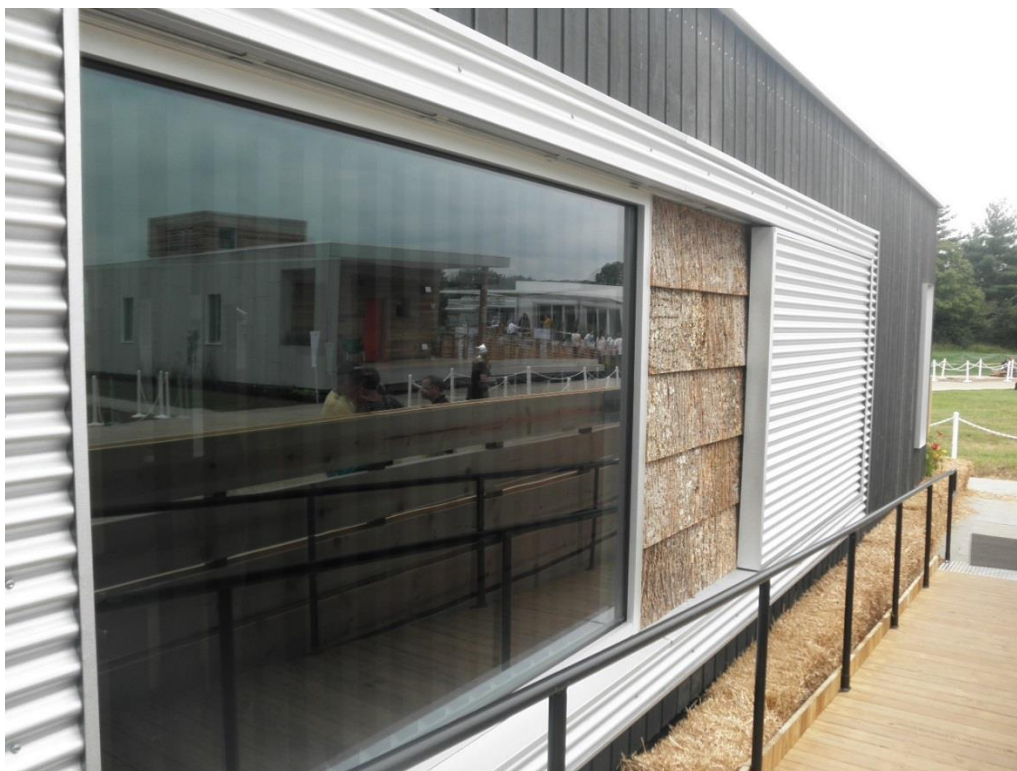
Рисунок 3. Использование наружных подвижных изолирующих штор 3 Темный цвет в экстерьере зданий часто используется, чтобы максимально поглощалось солнечное тепло и передавалось всему зданию.
