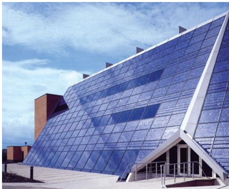
Рисунок 5. Гелиоустановки на фасадах зданий 5
