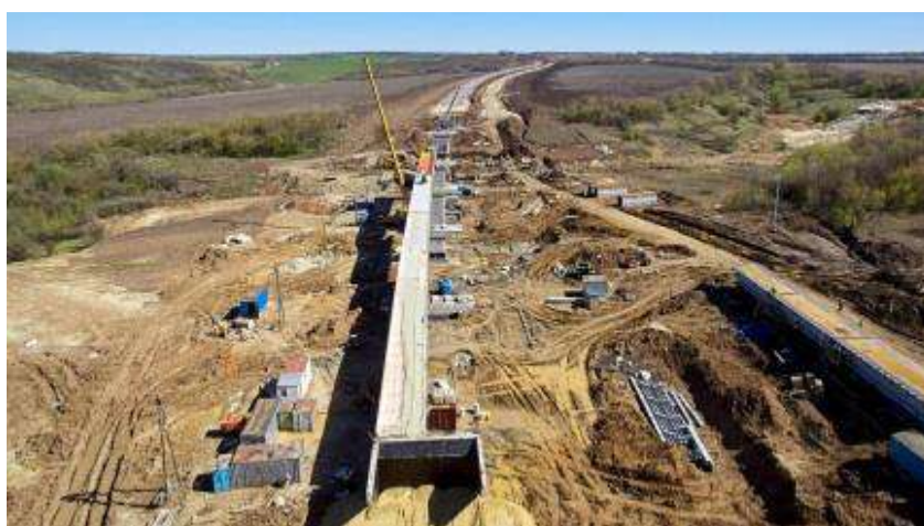
Рис. 1. Общий вид строительной площадки
