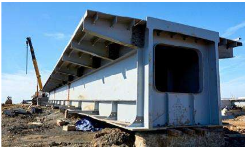
Рис. 2. Пролётное строение, собранное из блоков
