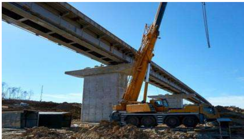
Рис.3. Монтаж пролётных строений автомобильным краном, грузоподъёмностью 300 тс
