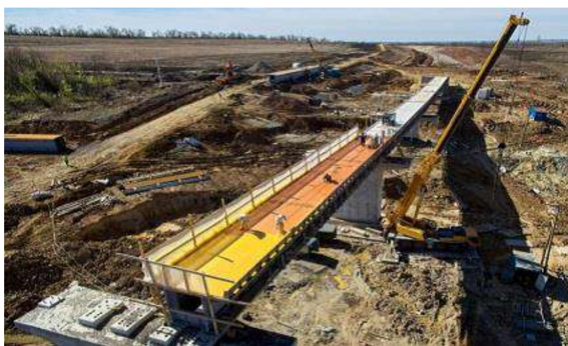
Рис. 5. Гидроизоляция корыта пролётных строений
