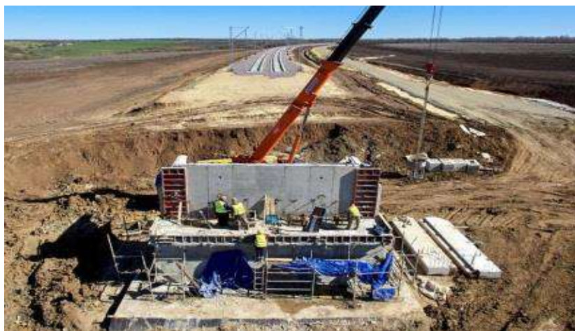
Рис. 4. Бетонные работы на устье
