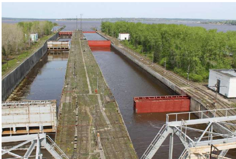
Рис. 2. Шлюз Пермского гидроузла
