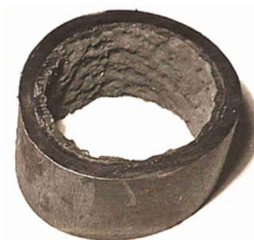
Рис. 1. Срез трубы со шлаковыми отложениями на внутренней поверхности
