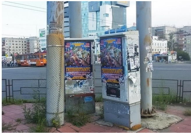
Рисунок 1. Реклама, размещенная на подстанциях
