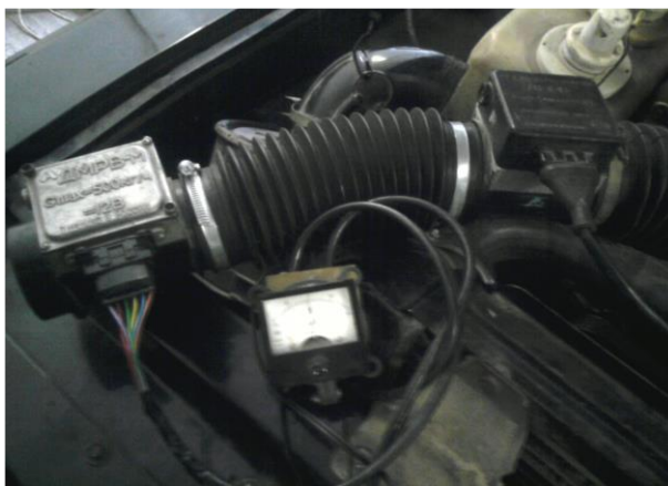
Рисунок 3.6 – Устройство для диагностирования ДМРВ на автомобиле в производственных условиях станции технического обслуживания «Интервал»
